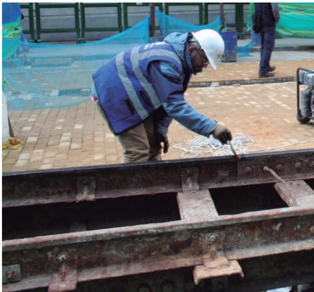
Intervención de rieles para su conservación. Fundación Erigaie (2015a)
