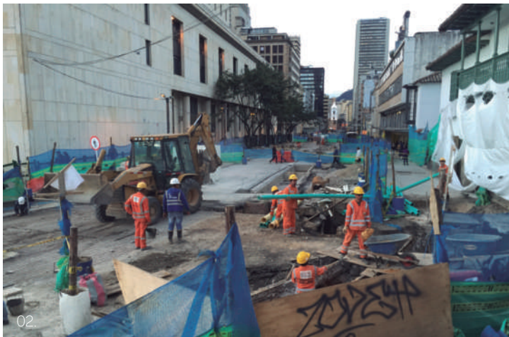
01. Demolición del parqueadero del Teatro Colón. Fundación Erigaie (2016d) - 02. Obras de impacto: peatonalización de la carrera 7ª. Fundación Erigaie (2015a)
