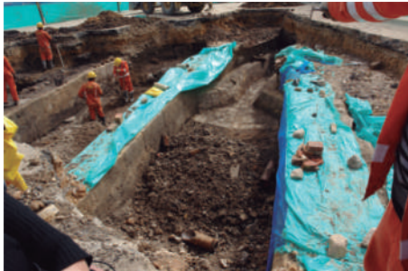
Excavación del puente Córdoba 1. Arango (2010).
